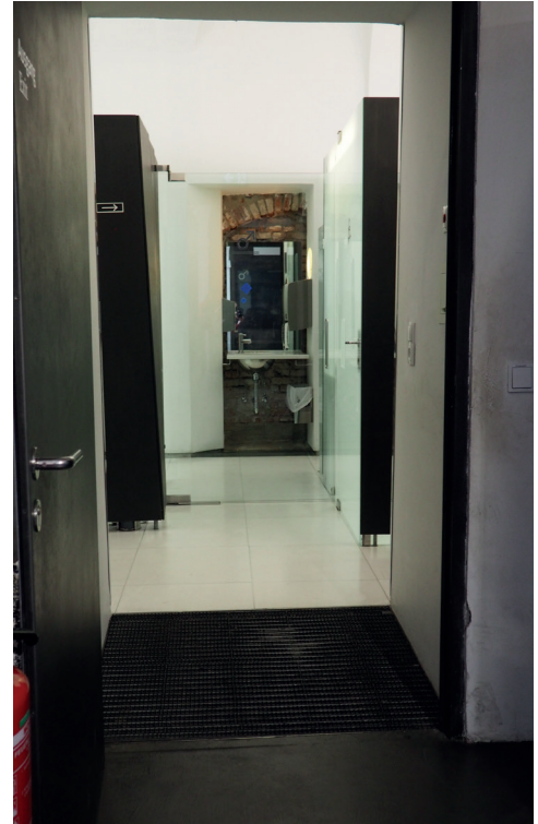
Zugang zu den WC's, Steigung 6%
