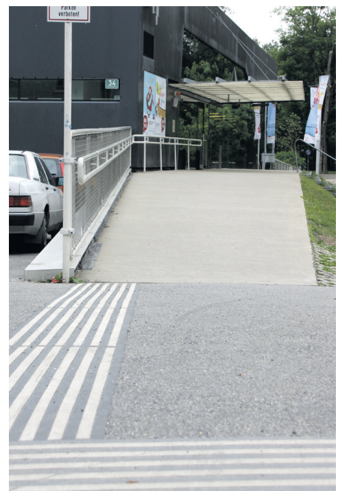
Zugang mit Rampe
