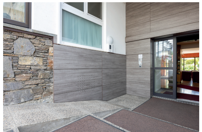
Steile Rampe zum Haupteingang
