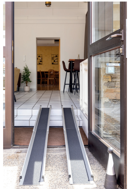
mobile Außenrampe zum Frühstücksraum
