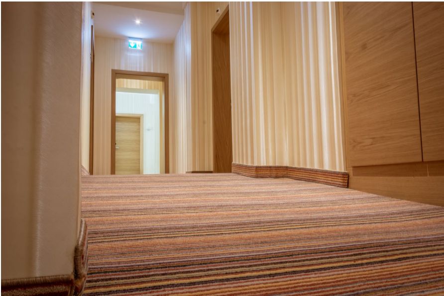
12% Steigung zu barrierefreien Zimmern
