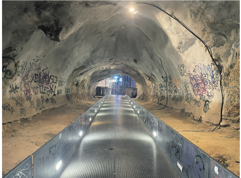
Rampe vom Lift zum Dom im Berg
